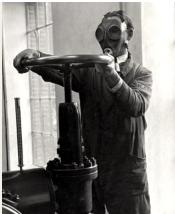
Een medewerker van de kunstijsbaan regelt de toevoer van ammoniakgas. Met vloeibaar gemaakt gas dat vervolgens verdampte, werd pekewater gekoeld. Deze pekewater stroomde door een buizenstelsel van 25 km in de betonnen vloer van de ijsbaan. Door hierop dunne laagjes water te sproeien ontstond een ijsvloer van drie centimeter. WIEL VAN DER RANDEN / SPAARNESTAD
